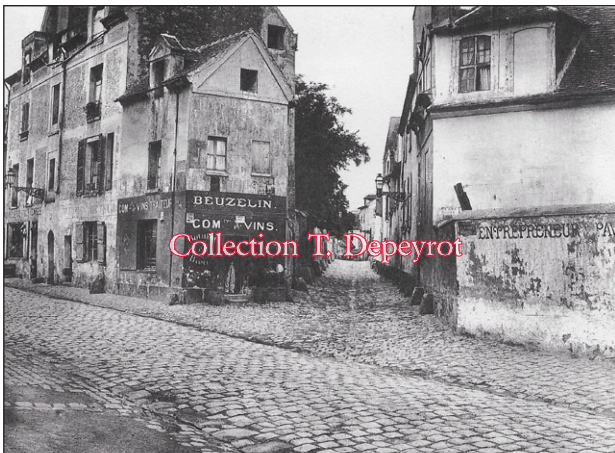
Rue de la Reine Blanche - Photo prise depuis la rue des Fossés-Saint-Marcel (en cette partie, rue Le Brun). Photo Marville vers 1865.
